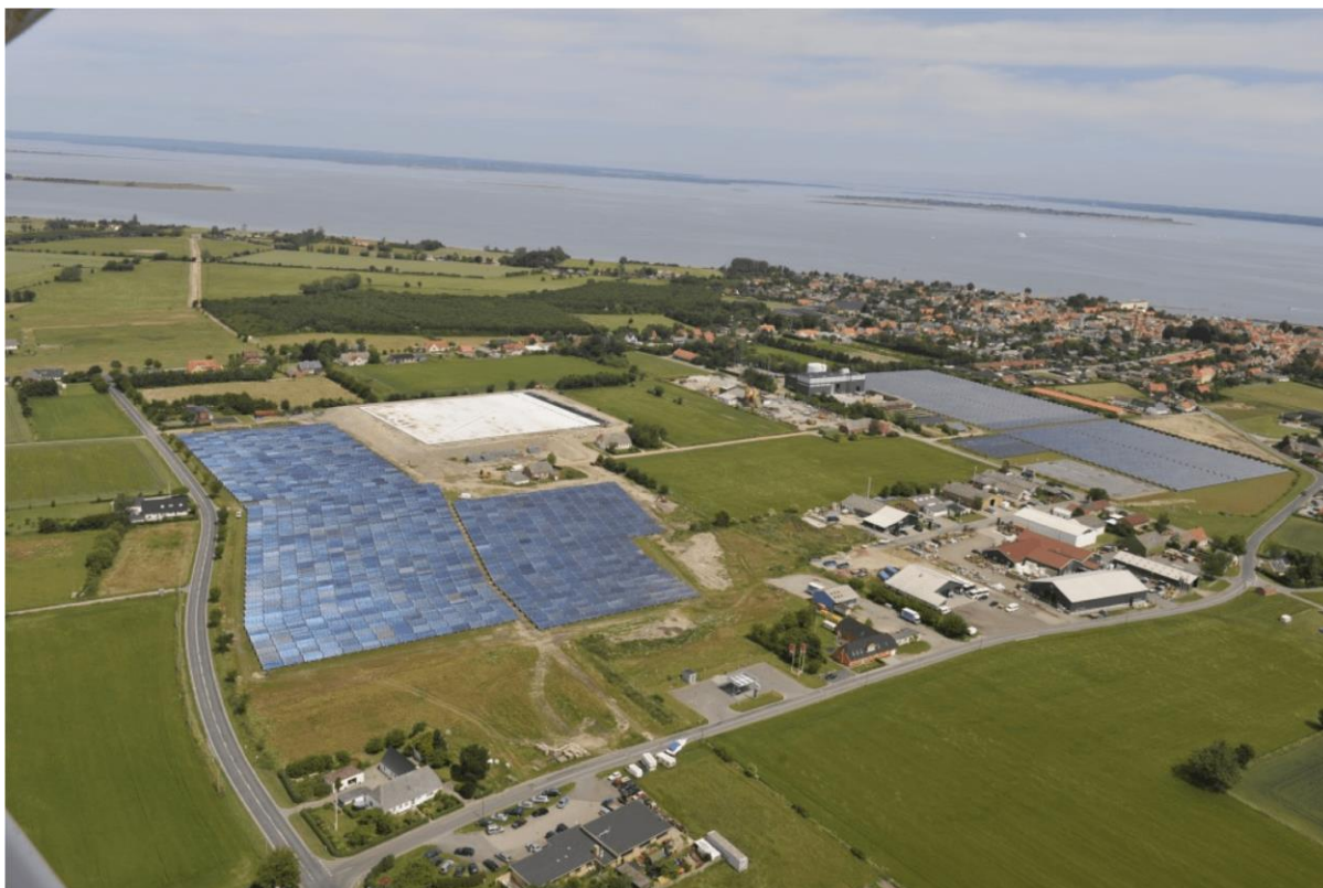
Rysunek 6. Kolektory słoneczne i system magazynowania ciepła w Marstal.
